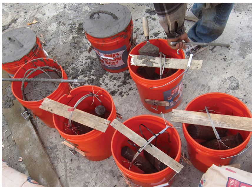
Figura21. Ejemplo de cómo se llenan de concreto, y unen las cubetas con cable de acero..
